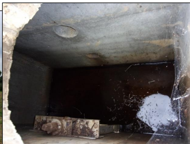
Photo 4 : Vue du bassin d'orage et de l'ouvrage de sortie, ZA La Ville Mouart
