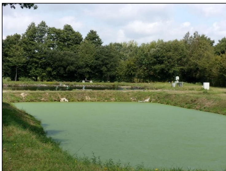
Photo 1 : Vue de la station d'épuration.
