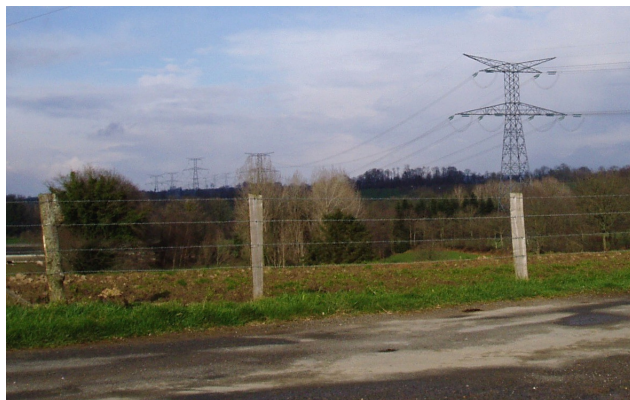
La ligne haute tension
