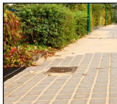
Pavé bétons avec joints sablés
