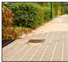
Pavé bétons avec joints sablés
