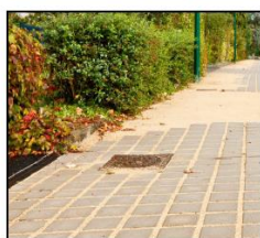
Pavé bétons avec joints sablés
