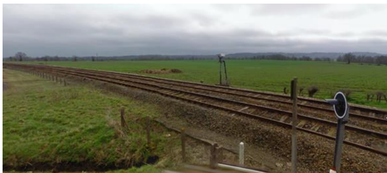
Photo de la voie ferrée
