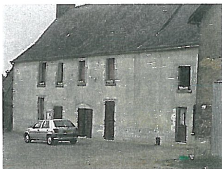
Bâti n°4 ferme de bourg R+1 ouvertures sous égout du toit homogènes et de mêmes gabarits
