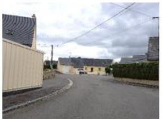
Les matériaux inappropriés de teintes trop claires
