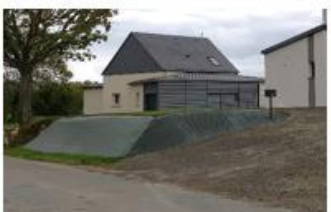
Les bâches sur talus
