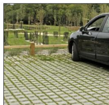
Pavé bétons avec joints engazonnés
