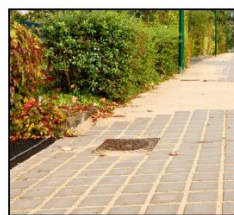
Pavé bétons avec joints sablés
