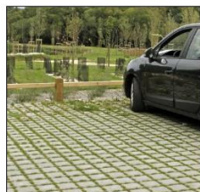
Pavé bétons avec joints engazonnés
