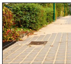
Pavé bétons avec joints sablés
