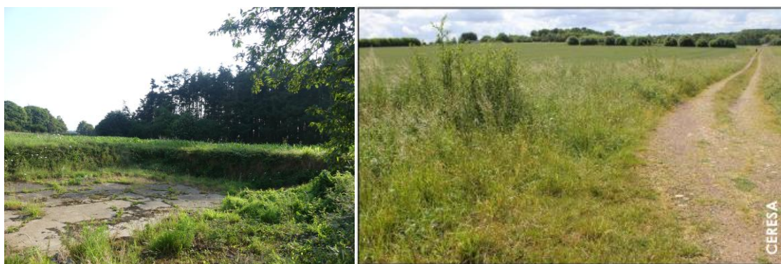
Clichés 11 et 12 : dalle de béton sur le site 3 (à gauche) et chemin sur le site 4 (à droite : source CERESA)
