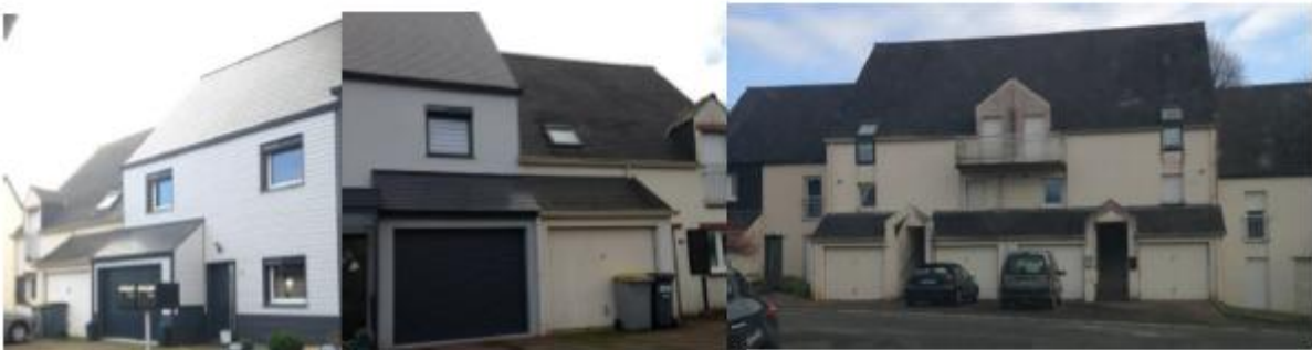
Des opérations groupées de plus de trente ans nécessitant une rénovation. Attention toutefois à la cohérence de l'ensemble.
