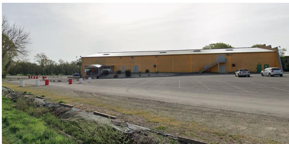
Le bâtiment existant
