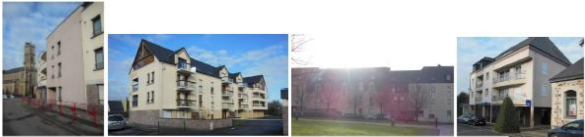
De constructions parsemées dans le bourg. Une intégration plutôt bien réussie.
