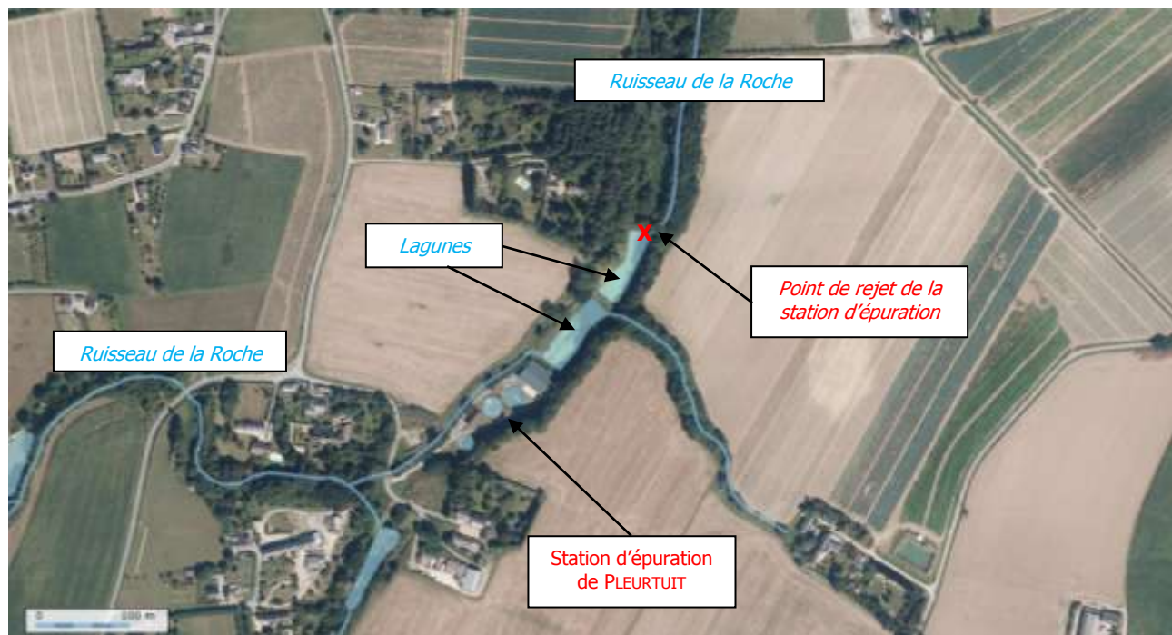
Fig. 4. VUE AERIENNE DU SITE DE LA STATION D'EPURATION DE PLEURTUIT
