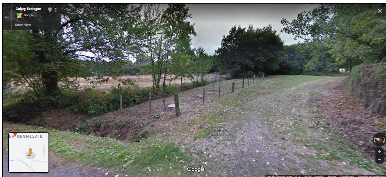
Figure 35 - Photographie Streetview de la station d'épuration de la Rennelaie (Google, septembre 2013)
