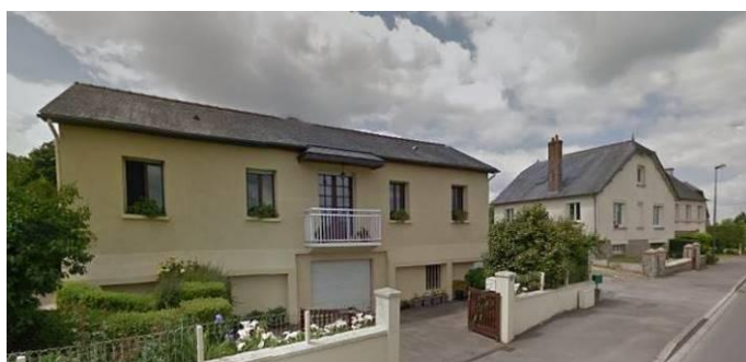
Construction au coup par coup – Rue de Rennes
