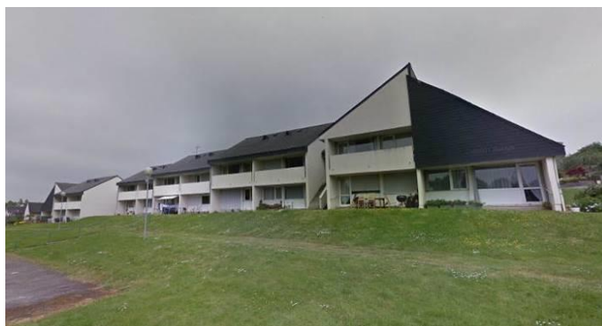
Logements intermédiaires – Rue du Val
