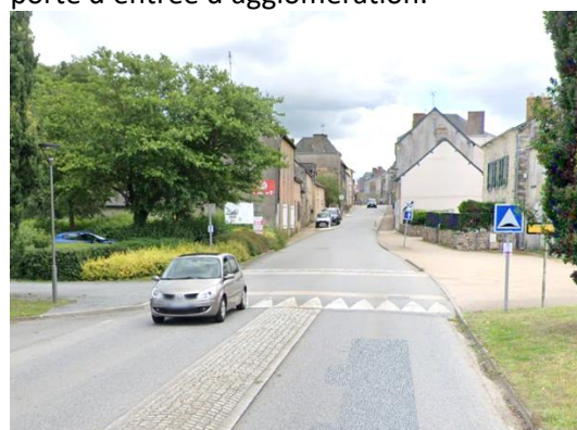
Exemple de Saint Ouen des Toits (53), entrée de bourg marquée par un plateau, traitement des espaces piétonniers en revêtement perméable, aire de co-voiturage en entrée d'agglomération masquée par la végétation.
