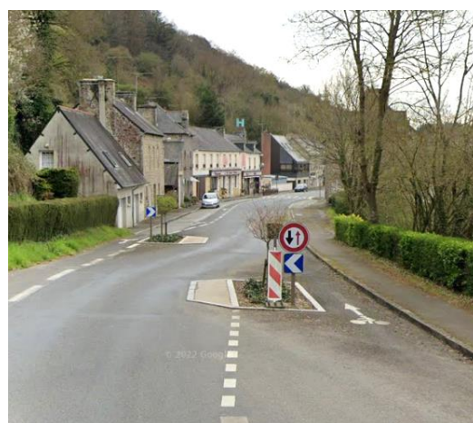
Exemple d'écluse sur RD en entrée de bourg à Jugon les Lacs (22) marquant un effet de porte d'entrée d'agglomération.
