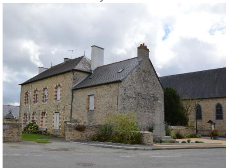
Ensemble bâti du Presbytère et de l'église
