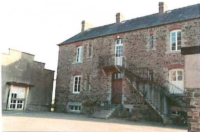
Bâtiment public, accueillant au rez- de chaussée les vestiaires du terrain de sports.
