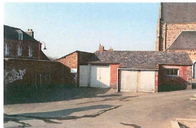
Bâtiment d'accueil des services techniques.
