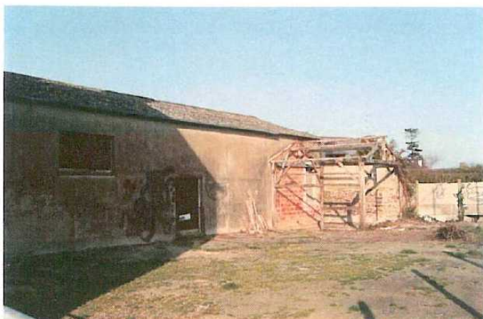
Bâtiment en cours de rénovation pour l'accueil des palétistes.
