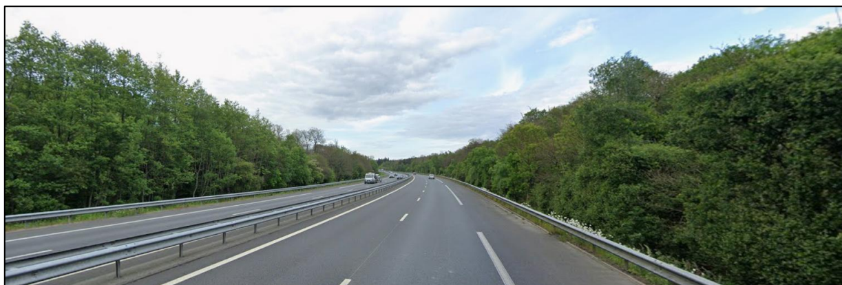
La RN 24 interrompt le Bois de Plessix sur plus de 600 mètres. (Source : Google Street View)
