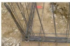
Nœud de chaînage - Continuité mécanique
