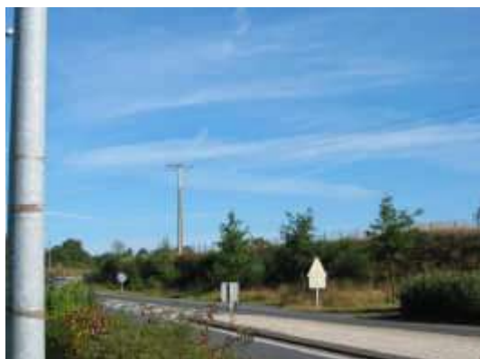
Rocade ouest entre talus
