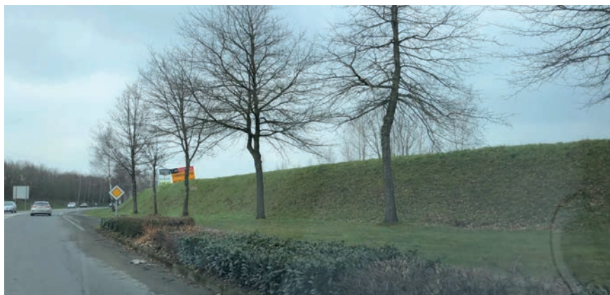
Talus existant le long de la RD n°706
