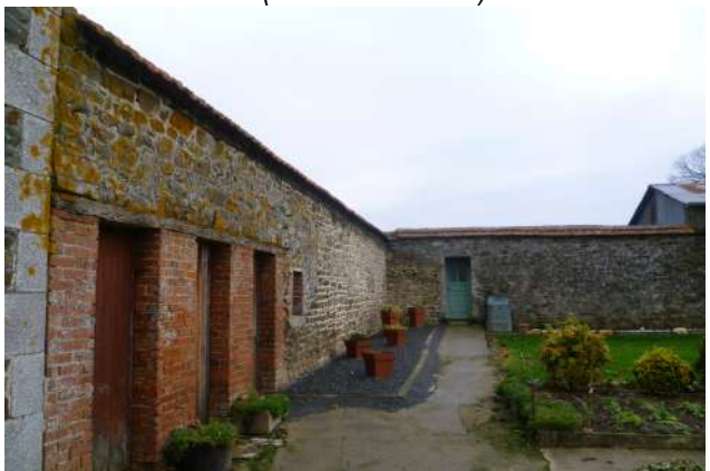
La Haute Chararie (bâtiments 1 et 2)
