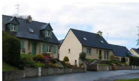
Lotissement de la Butte Les remblais sont nécessaires pour la construction des maisons
