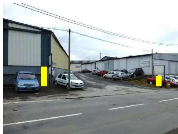
Les bâtiments G et C en surplomb sur la rue de la Croix Dorée
