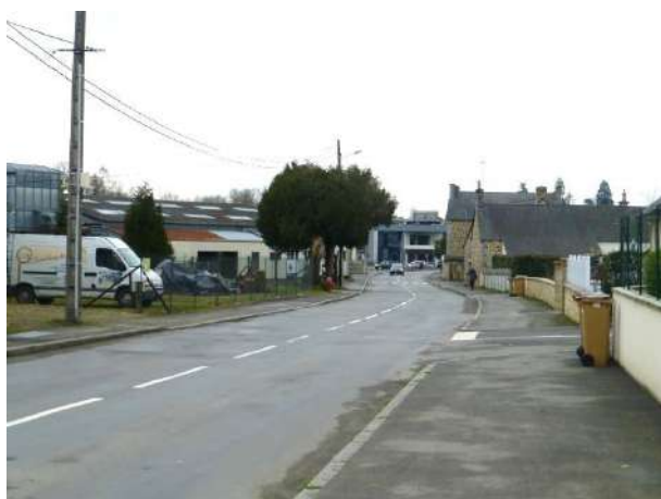
Rue de la Croix Dorée : les bâtiments suivent la pente de la rue
