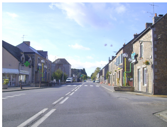
Constructions anciennes le long de l'avenue Victor Hugo
