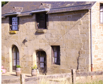
Encadrement de porte, La Basse Bourdière
