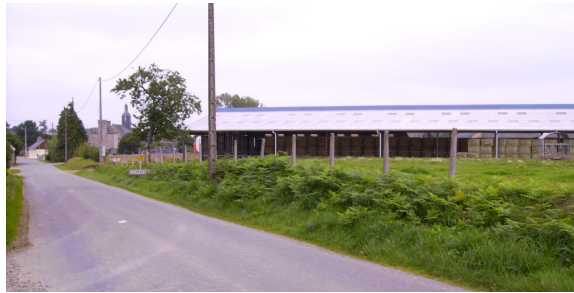
Bâtiment agricole, entrée de bourg est
