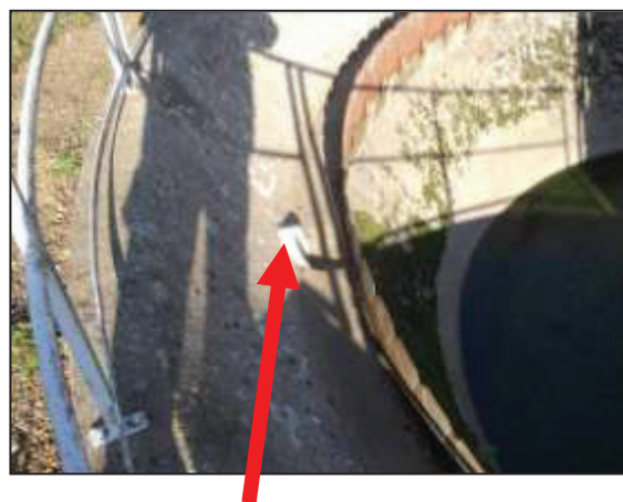
Trop plein du bassin tampon.
