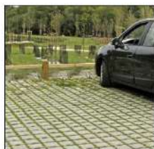
Pavé bétons avec joints engazonnés
