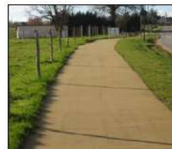
Sablé stabilisé renforcé
