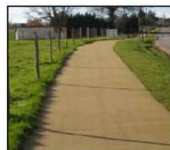
Sablé stabilisé renforcé
