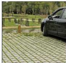
Pavé bétons avec joints engazonnés
