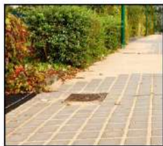
Pavé bétons avec joints sablés
