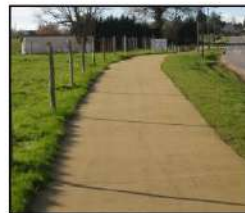
Sablé stabilisé renforcé
