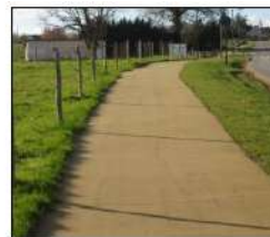
Sablé stabilisé renforcé
