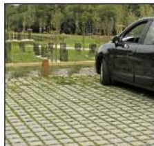
Pavé bétons avec joints engazonnés
