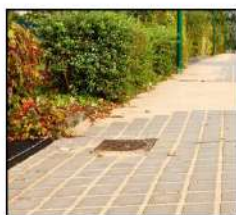
Pavé bétons avec joints sablés
