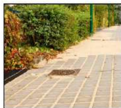
Pavé bétons avec joints sablés
