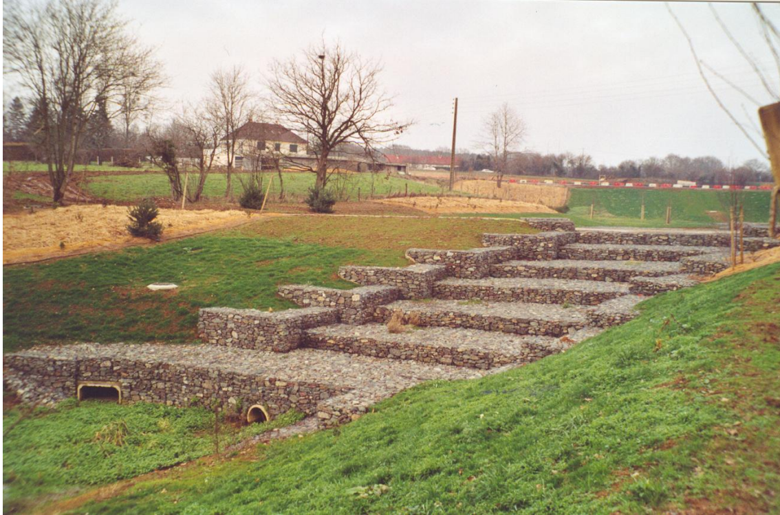
Déversoir en Gabions de forme escalier
