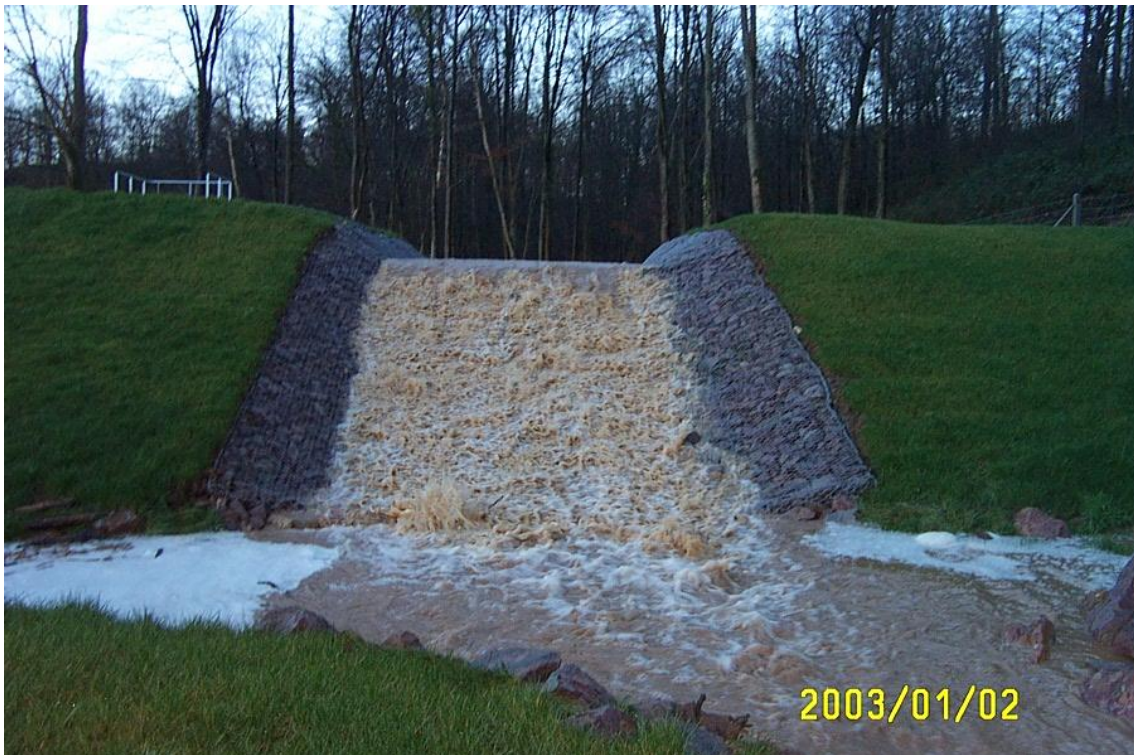
Déversoir rectangulaire en gabion
