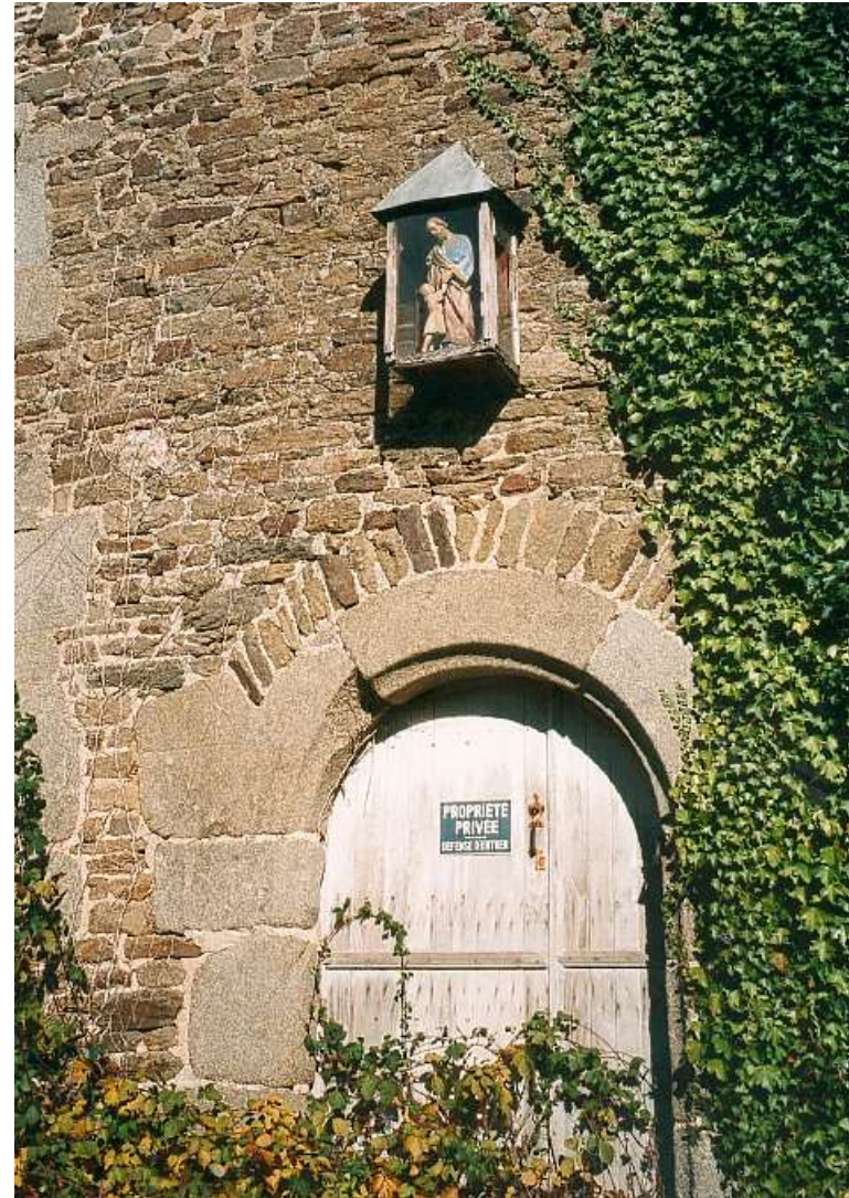
Ce ardoise. Une porte plein cintre moulurée a été réemployée.
