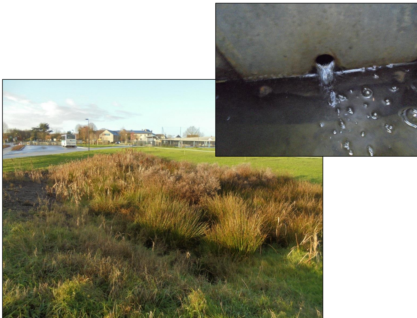
Photo 2 : Vue du bassin d'orage de l'école publique et de l'orifice de fuite de l'ouvrage de sortie
