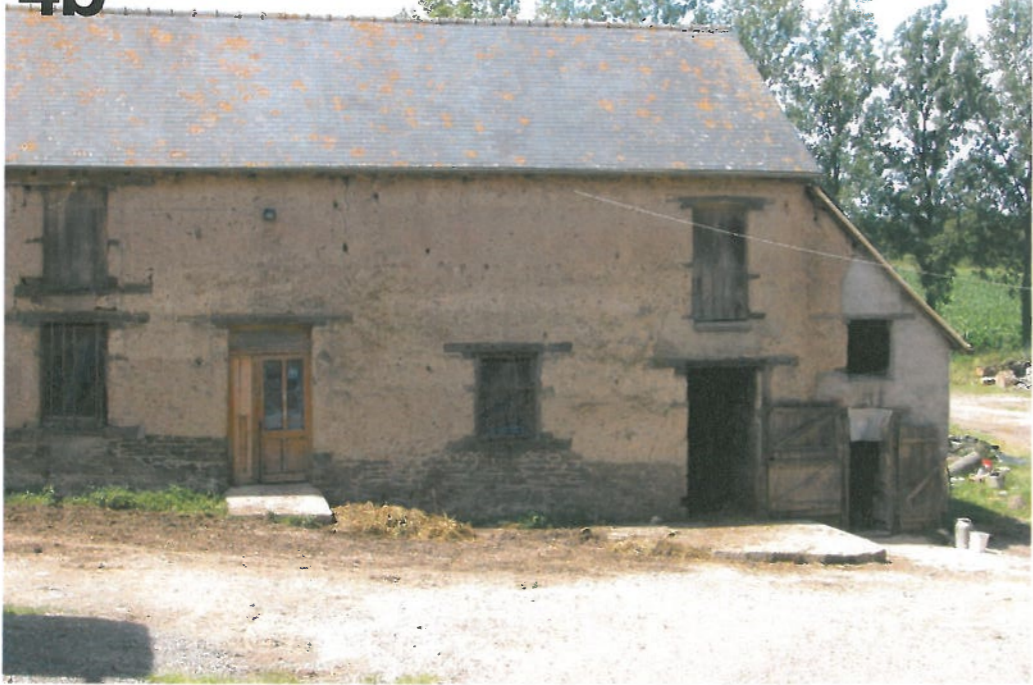
La Regnerais : Cet ancien manoir date de la fin du XVe siècle (photo 4a). Le bâtiment principal a été rénové et sert d'habitation. Il comporte plusieurs granges ou dépendances qui mériteraient d'être restaurées (photo 4b). Il sert actuellement de siège à une exploitation agricole
