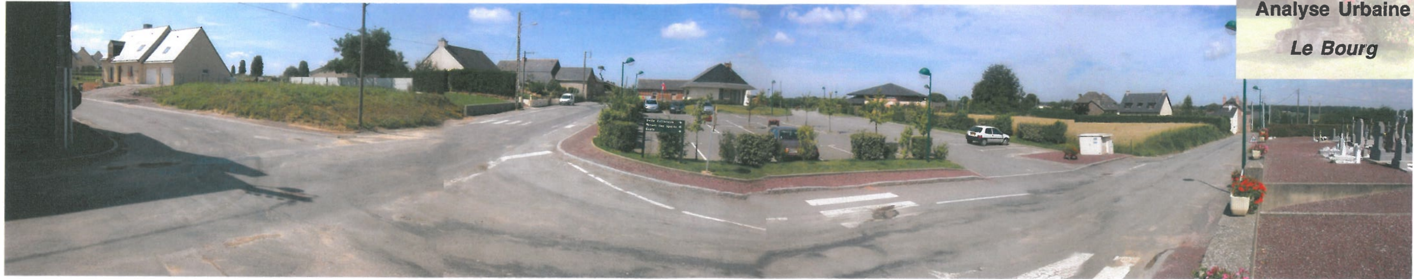
▲ Vue depuis le cimetière de l'église sur la mairie au fond, le parking communal devant, la RD 59 et l'emplacement de tous les lotissements sur la gauche. Il reste encore des terrains disponibles pour densifier le bourg.
