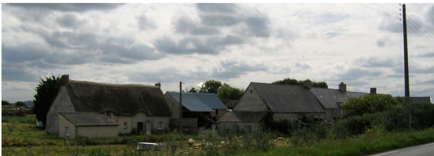
Longères s'appuyant sur la digue, disposées en contre-bas.
