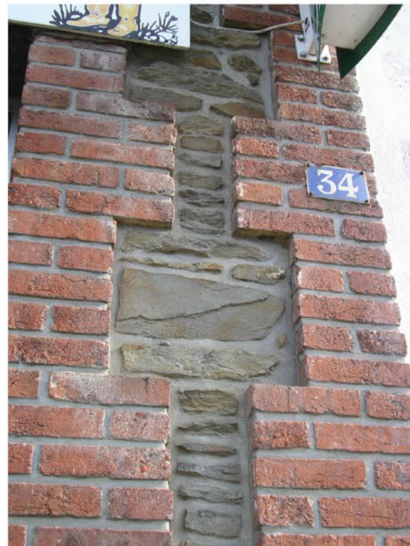
Brique en saillie : façade destinée à être enduite
