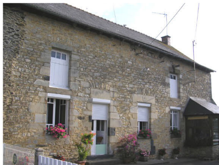
Pierres blanches en façade principale
