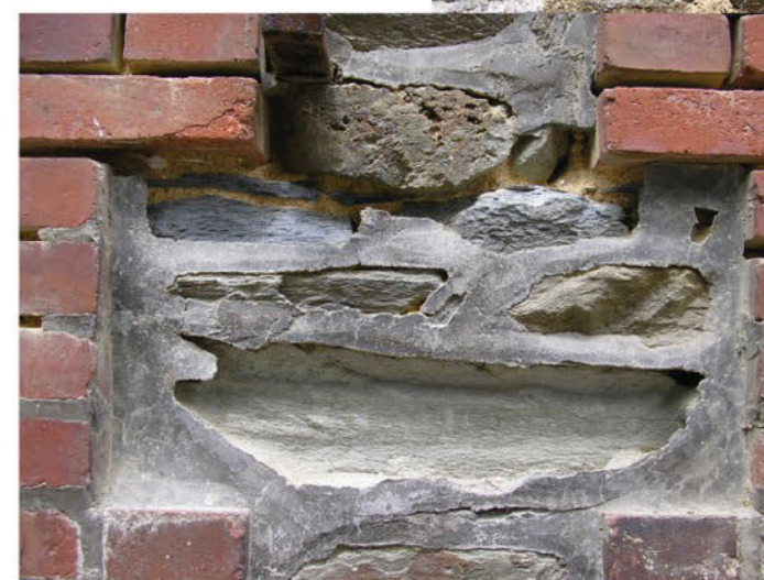
Joints ciment entraînant l'altération de la pierre
