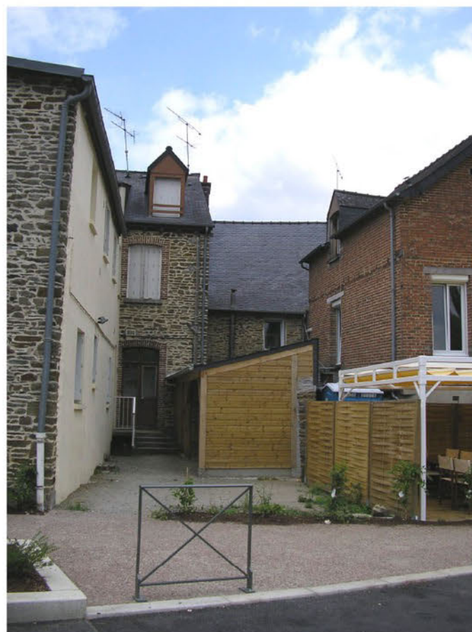
Accès depuis le parking du Gué
