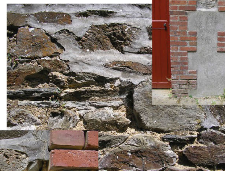
Joints ciment entraînant l'altération de la pierre
