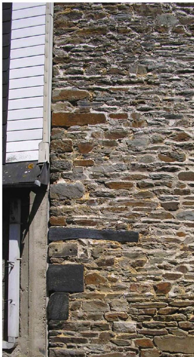
Chaînage d'angle en schiste
