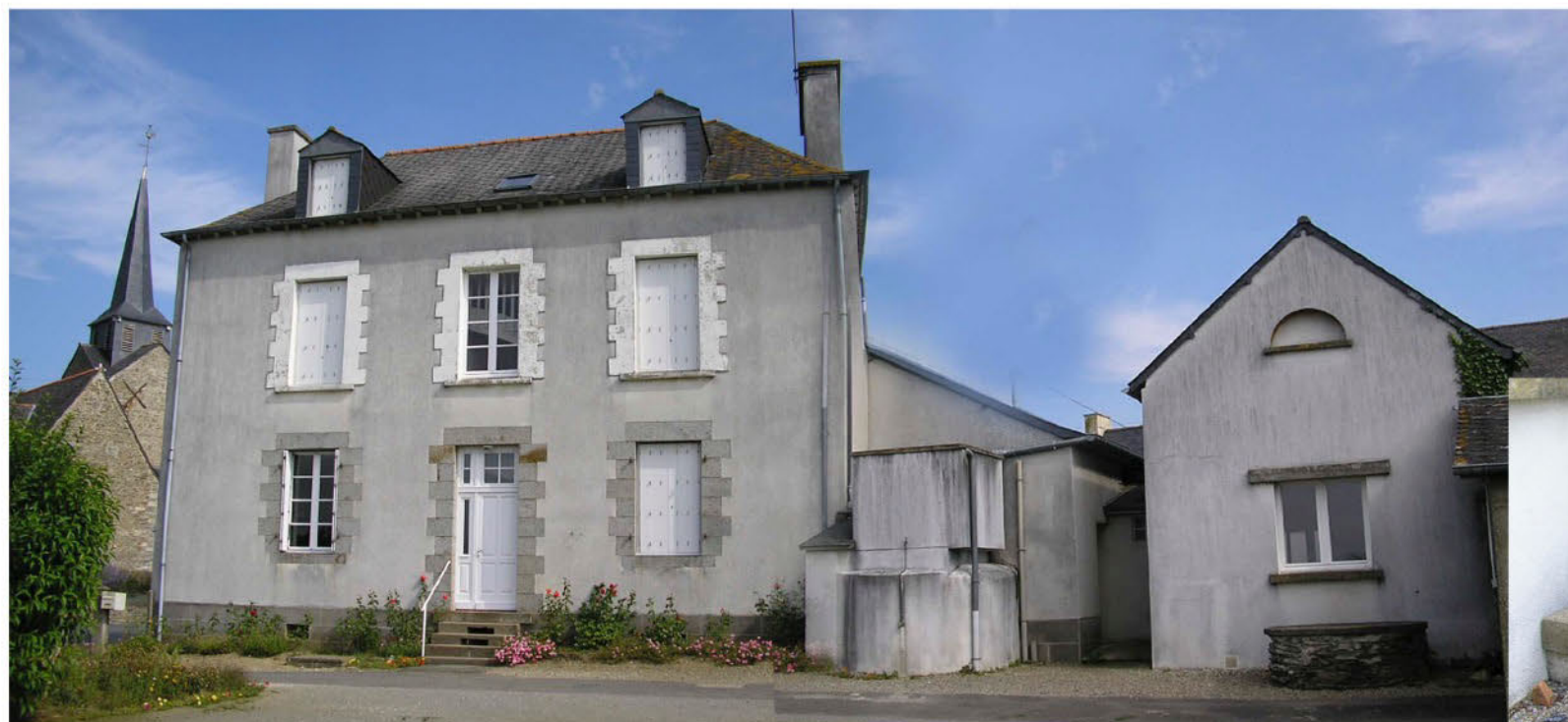
Façade arrière avec l'ancien puit
