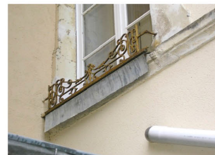
Garde corps inversé – façade arrière
