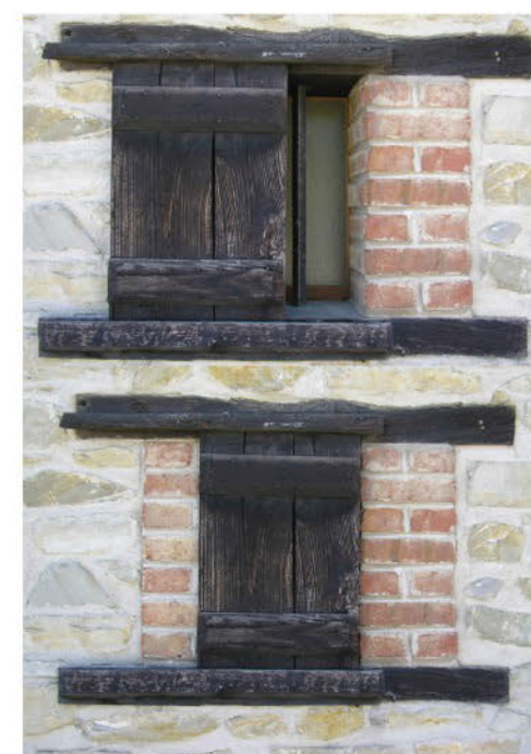
Fermeture d'origine des petites baies par un système de volets coulissants en bois
