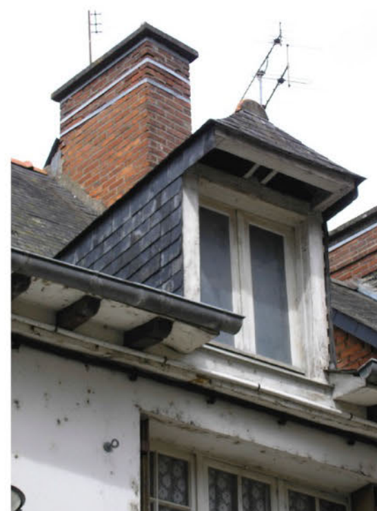
Gerbière en façade principale
