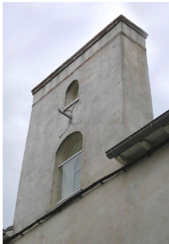
Souche de cheminée avec niches
