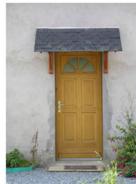
Création d'une porte contemporaine en façade nord enduite au ciment...
