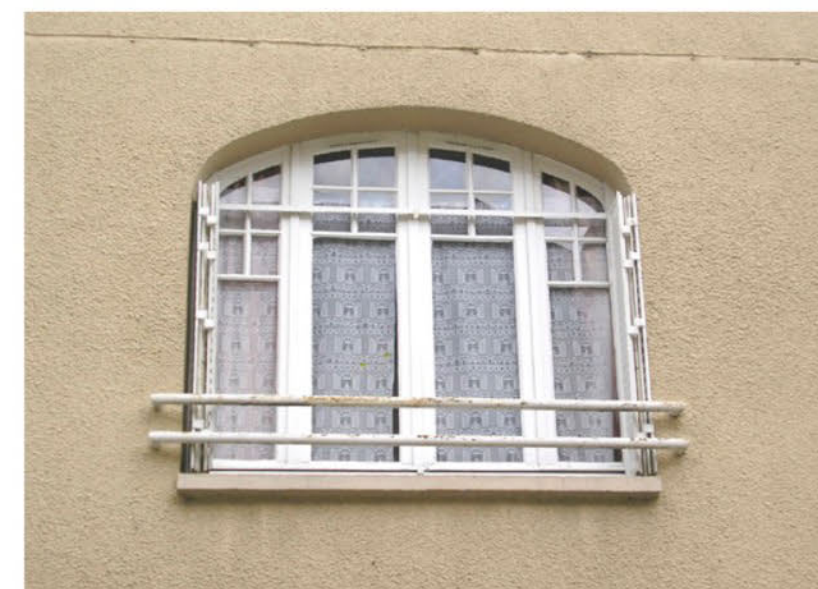
Fenêtre 1 er étage sur rue
