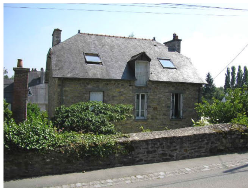
Façade arrière depuis la rue des Manoirs
