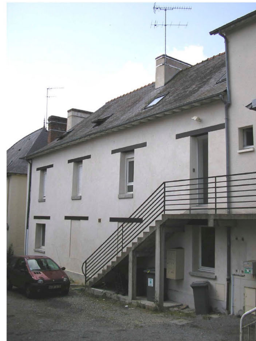
Façade arrière, accès aux logements
