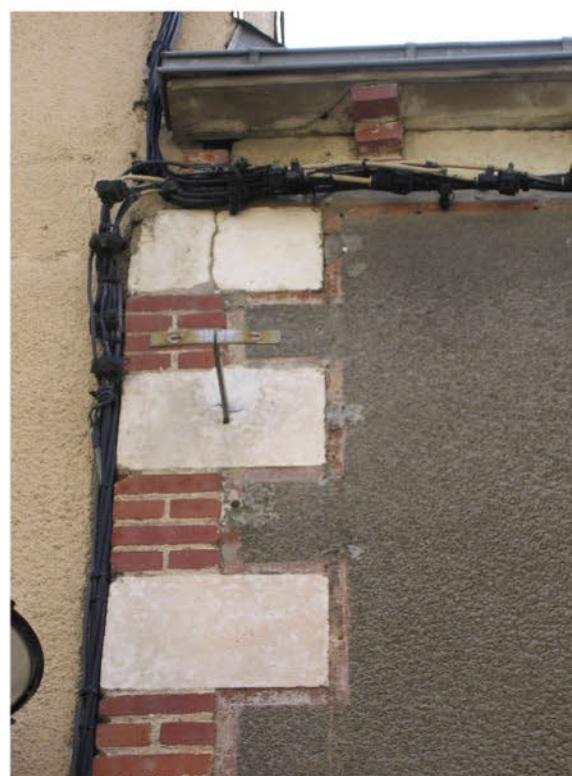
Chaînage d'angle et corniche en brique et pierre blanche
