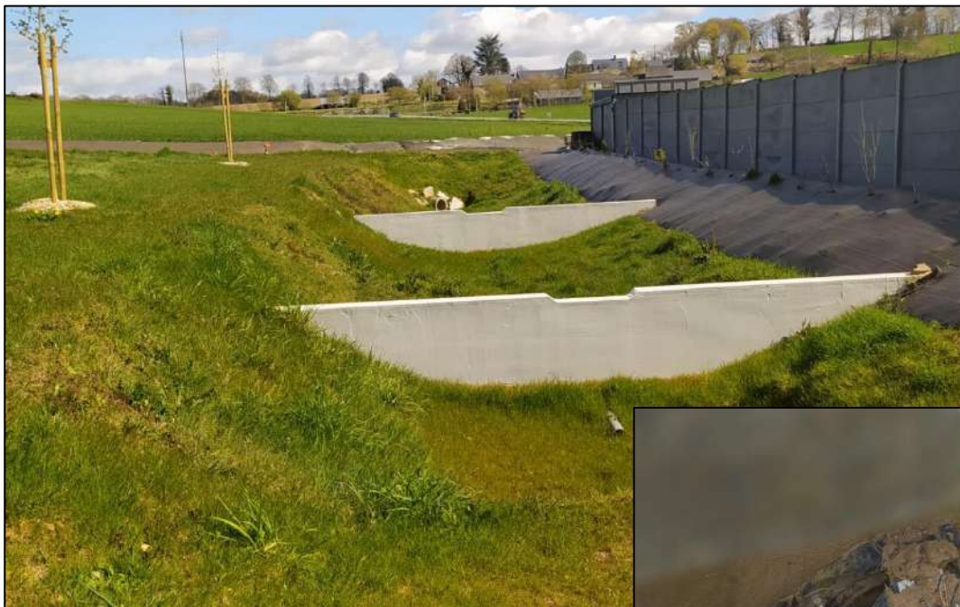
Photo 3 : Vue du bassin d'orage 2 et de l'ouvrage de sortie du lotissement « Les Coteaux 3 »
