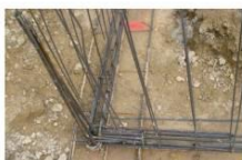
Nœud de chaînage - Continuité mécanique
