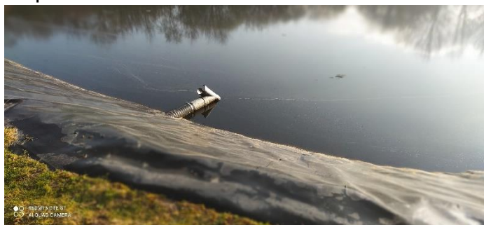
Premier bassin étanche
