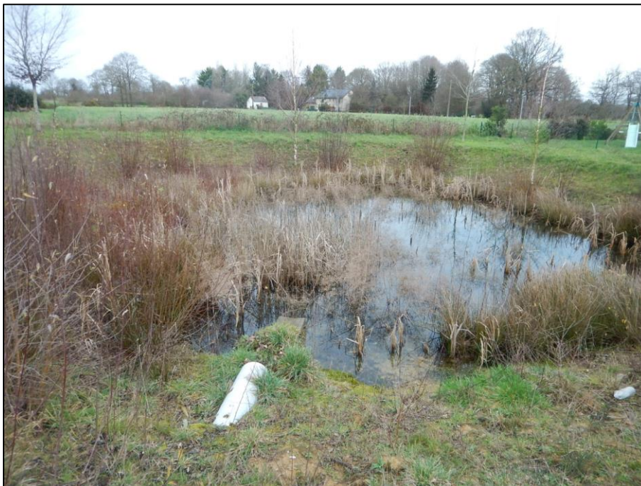
Photo 4 : Vue du bassin d'orage du lotissement « le Clos Volais »
