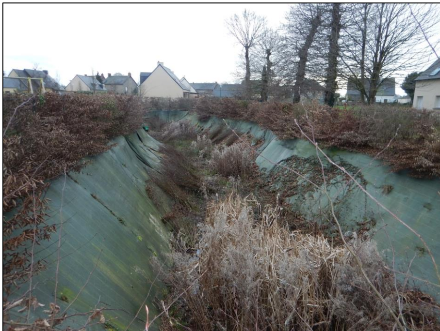
Photo 3 : Vue du bassin d'orage du lotissement « le Clos Breton »
