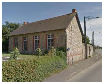
Ancienne école : la modénature des menuiseries seraient à conserver.
