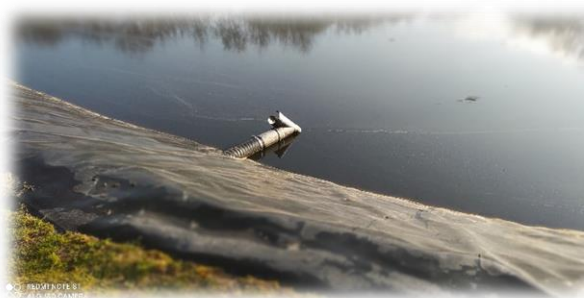
Premier bassin étanche
