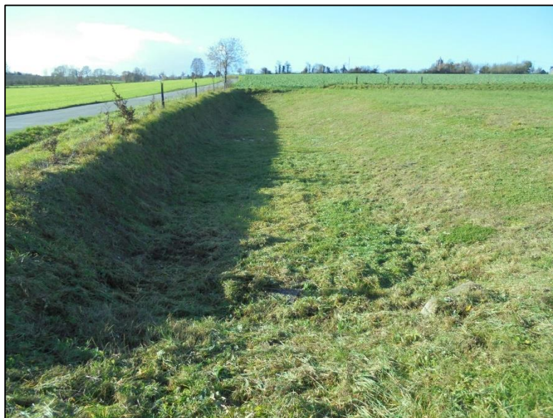
Photo 1 : Vue du bassin d'orage de la zone d'activité
