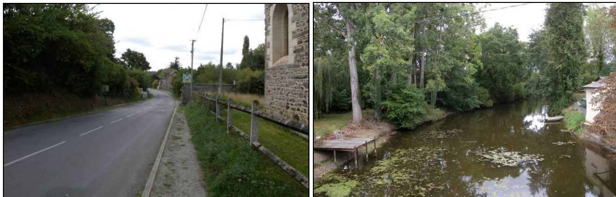
Sorti des promenades, le cours d'eau se découvre majoritairement depuis les routes, au niveau des ponts.
