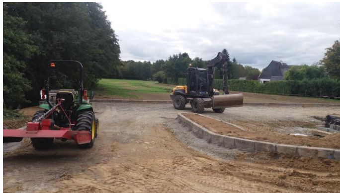
Parking face au parc de Pré Belay
