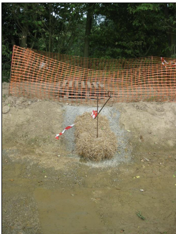
Photo 3 : Emplacement du filtre à particules fines (botte de paille) pendant la phase des travaux au niveau du bassin d'orage
