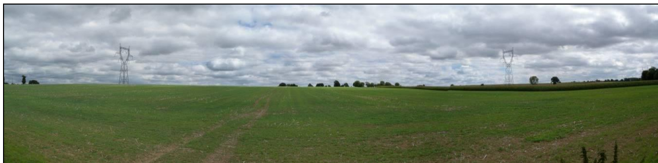
La ligne haute-tension, un signe marquant de l'urbanisation en campagne.
