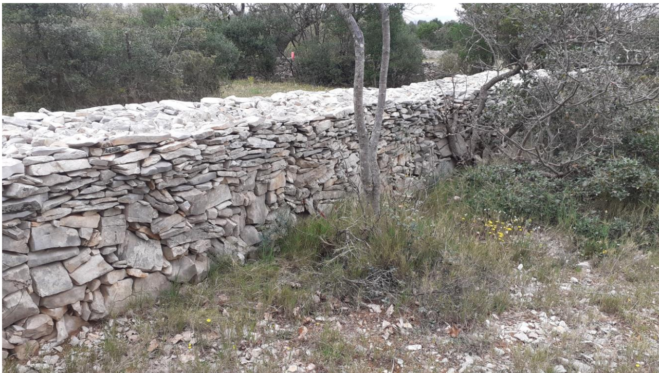
Photo 6. Mur de pierres sèches
