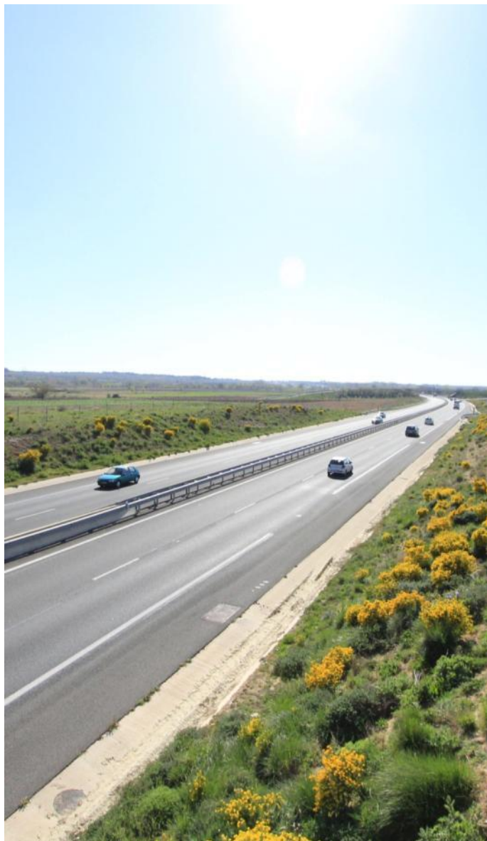
Vue de l'A75 en déblais au niveau du pont de la RD125. Axe majeur fragmentant le territoire, il contourne le bourg.
