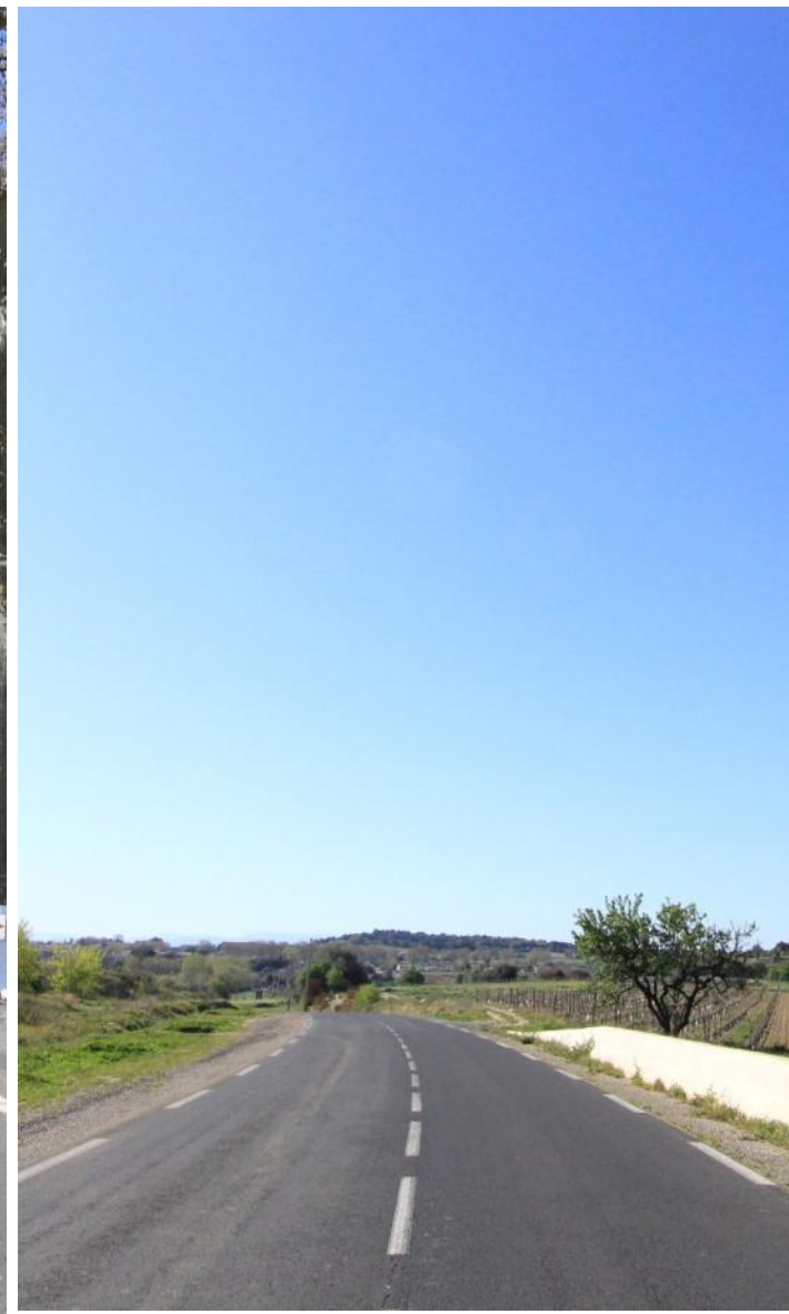
Vue de la RD125E3 à l'Est du bourg vers celui-ci. Axe rural de large gabarit, il traverse le bourg sous forme de rues plus étroites.
