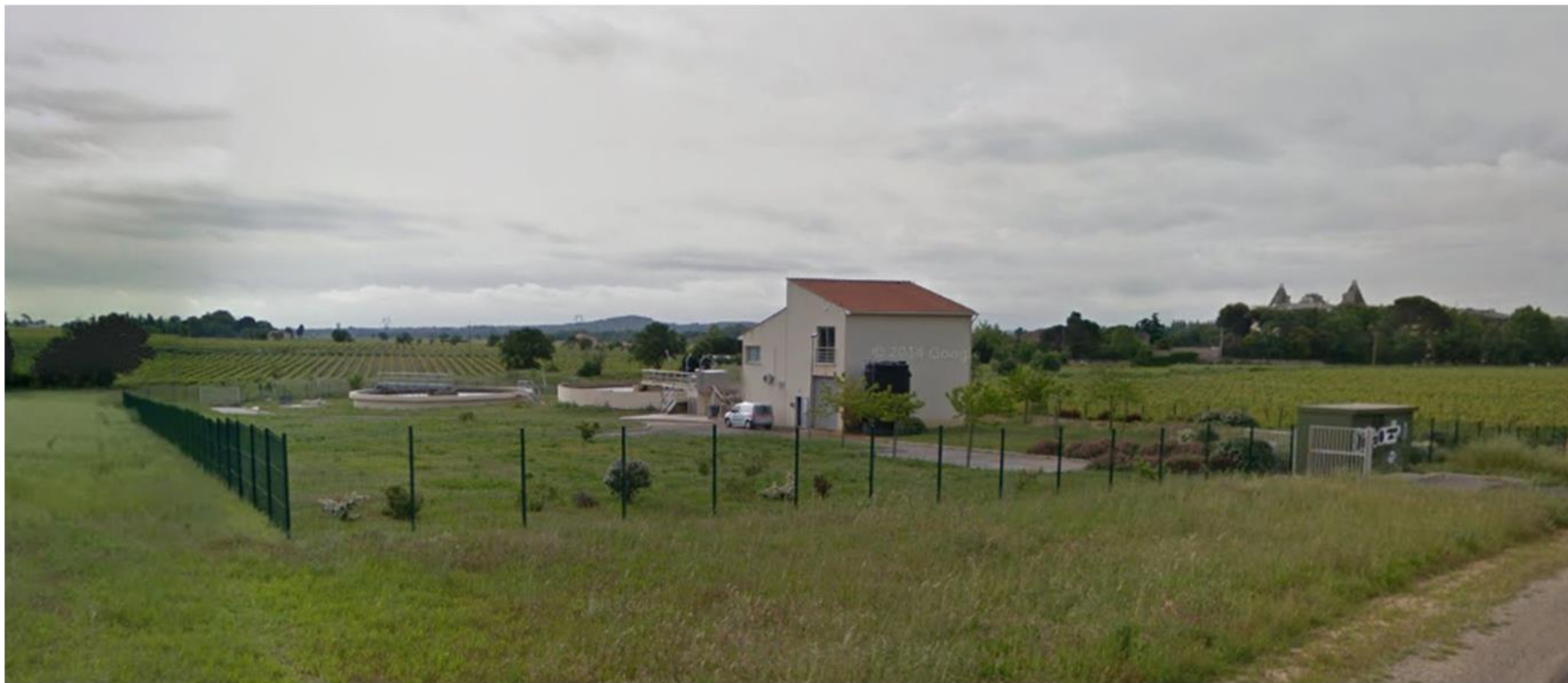
Station d'épuration du S.I.V.U Montblanc – Valros
