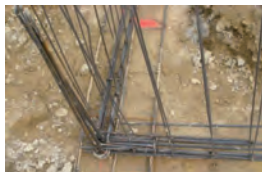
Nœud de chaînage - Continuité mécanique
