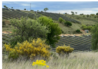
Perception rapprochée : respect de la topographie, les panneaux ne sont pas installés sur les terrains en forte pente, aménageant ainsi un retrait des panneaux de part et d'autre de la cassure de pente. La préservation des bosquets arbustifs permet une intégration harmonieuse. © Françoise Gaillard, paysagiste conseil de l'État
