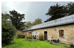
Toiture photovoltaïque, Douarnenez. © Fabien Sénéchal (ANABF)
