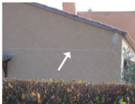
Fissuration traduisant un décollement de la structure par absence de liaisons entre niveau bas et combles.
