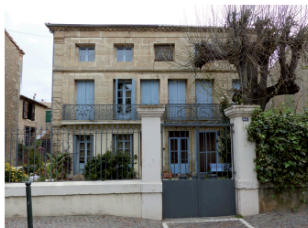
Façade en pierre de taille
