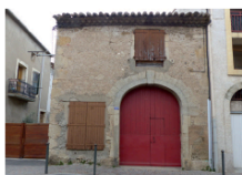
Ancienne remise agricole
