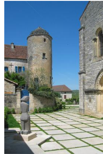
Ci-dessus : place publique et aire de stationnement présentant des traitements de sols limitant l'imperméabilisation et favorisant l'infiltration directe des eaux de pluie.
