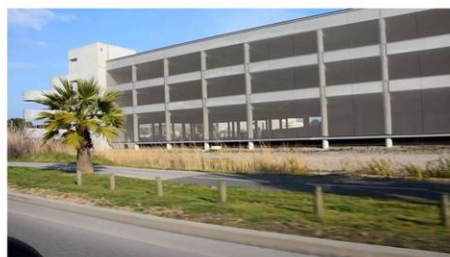
"Effet mur" du parking à étages
