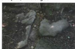
Chemin empierré, Canroute
