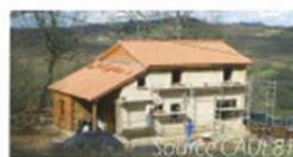
Auto-construction en paille, isolation liège
