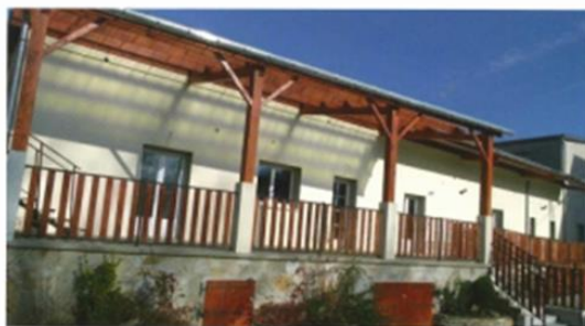
Rénovation d'un atelier industriel en logements, Sidobre
