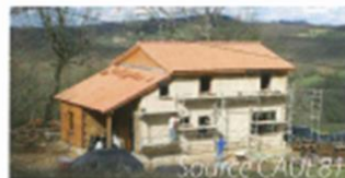
Auto-construction en paille, isolation liège
