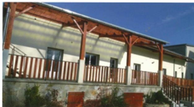
Rénovation d'un atelier industriel en logements, Sidobre
