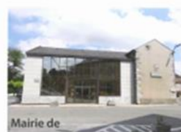
Mairie de Saint-Salvy-de-la-Balme
