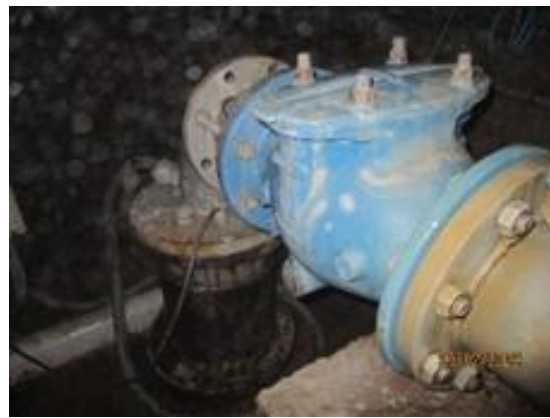
Vue du forage Ouest (intérieur bâti)
