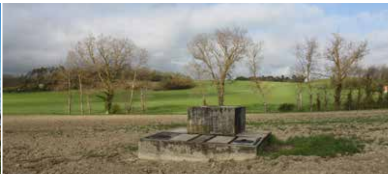
Exemple d'un dispositif d'irrigation sous forme de regard en béton semi-enterré au cœur d'une parcelle agricole.
