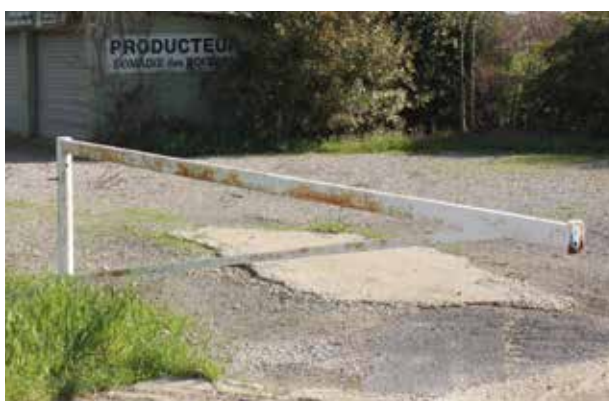
Barrière métallique vieillissante
