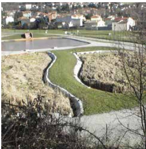
Bassin de décantation
