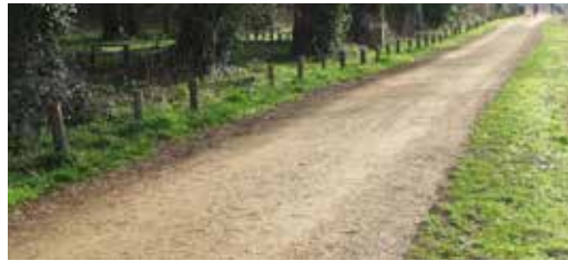
Revêtement stabilisé à liant hydraulique similaire à celui retenu pour la véloroute du canal des 2 Mers, avec un rendu proche de celui des chemins de halage
