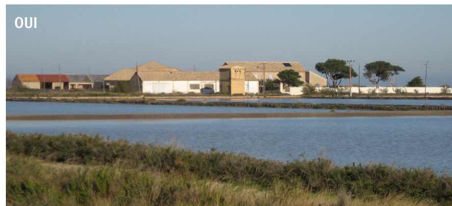
Un exemple de bâtiments d'activité en groupe aux proportions harmonieuses et bien intégrées aux abords du Canal et marais, la teinte mériterait d'être moins blanche.
