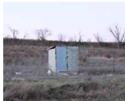
Exemple d'un abri à pompe avec une mise en oeuvre sommaire des matériaux.
