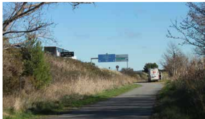
Illustration d'une auto route avec un talus qui a un impact prégnant dans le paysage du site classé.
