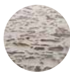
Enduit à pierre-vue
