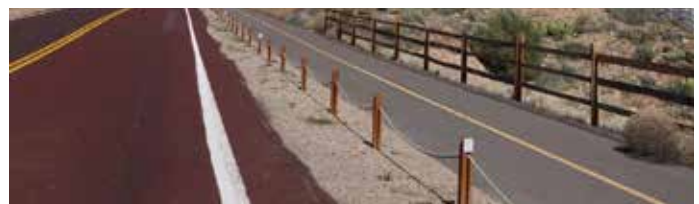
Route de teinte faisant écho à la pierre locale - Aménagement qualitatif des abords
