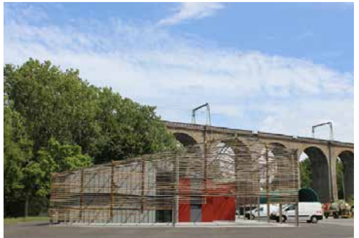
Station d'épuration de Limoges - ATELIER 4 LIM ARCHITECTES
