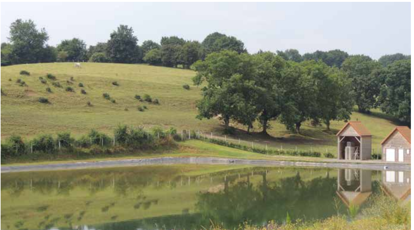
Station d'épuration par lagunage naturel à Rubempré - Floursies - Hydram
