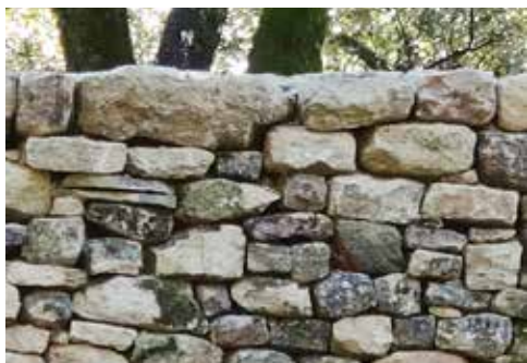
Muret pierres sèches à double parement
