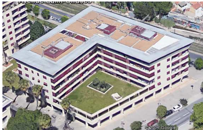
Figure 72: Avenue Saint Charles toit végétalisé
