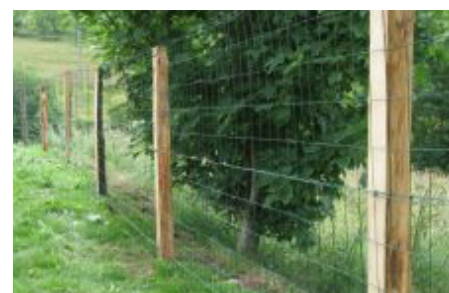
Poteaux bois et grillage noué
