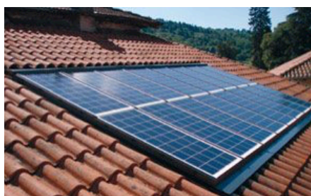
Implantation admise, suivant la pente de la toiture
