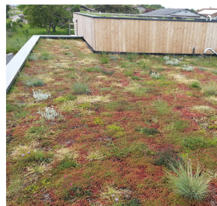
Végétalisation en toiture
