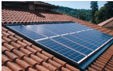
Implantation admise, suivant la pente de la toiture, ou dissimulés par les acrotères
