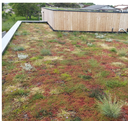
Végétalisation en toiture
