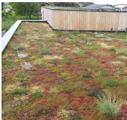
Végétalisation en toiture
