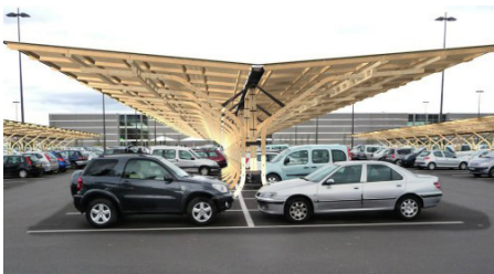
Traitement des ombrages photovoltaïques
