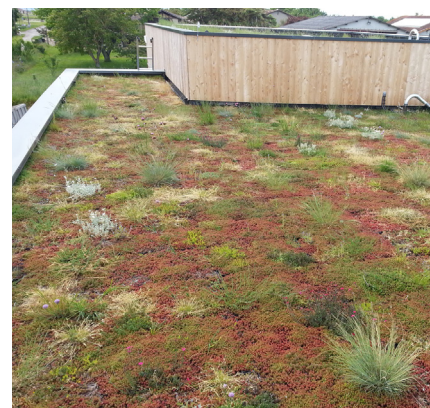
Végétalisation en toiture
