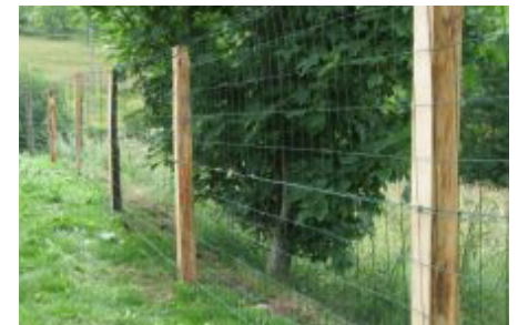
Poteaux bois et grillage noué
