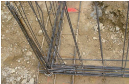
Nœud de chaînage - Continuité mécanique
