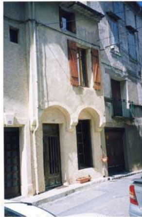
4 Maison de village sur encorbellement
