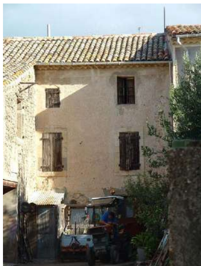
91, rue de la révolution façade 1816
