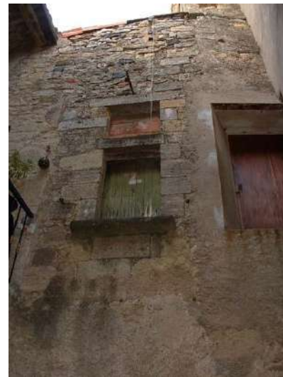
36 bis rue de la Tour
