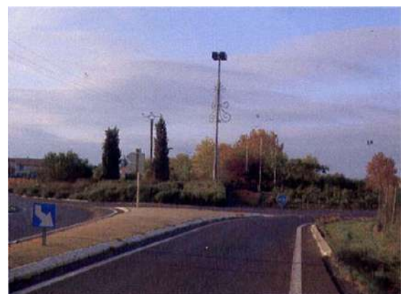
Le rond-point à l'entrée Est du bourg semble disproportionné. Il dénote avec le paysage viticole alentours et ne met pas en valeur l'entrée du bourg
