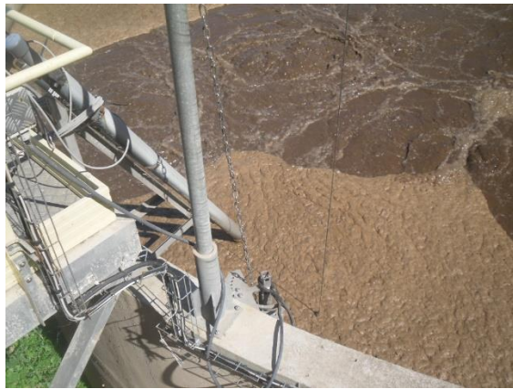
Vue structurelle du bassin d'aération 1
