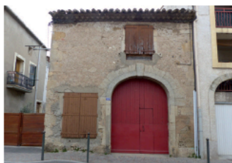
Ancienne remise agricole
