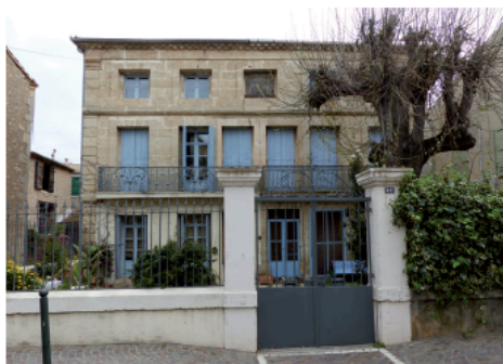
Façade en pierre de taille
